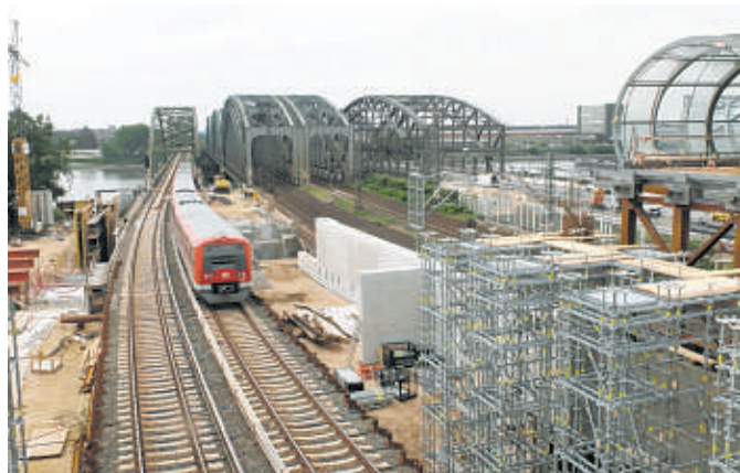
Hier entsteht der S-Bahnhof Elbbrücken, per Skywalk (rechts) verbunden mit dem neuen U-Bahnhof
